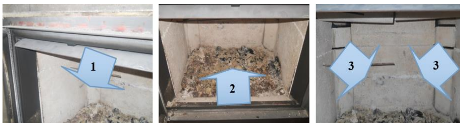
Modyfikacja systemu doprowadzania powietrza do paleniska
