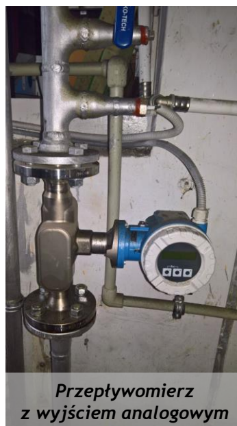
Przepływomierz pary, zawór redukcyjny
