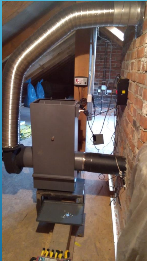
Pierwsza instalacja, kocioł węglowy, palnik tłokowy 25 kW
